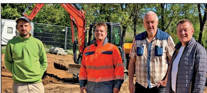
(von links) Steven Dietrich (Baufirma), Martin Prühl (Stadt Ochsenfurt), Stadtbaumeister Roland Zinn und Bürgermeister Peter Juks informieren zur Baumaßnahme eines Mehrgenerationenplatzes in der Ochsenfurter Westsiedlung. Text und Bild: Walter Meding
