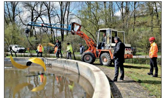
Das neue Rührwerk wird auf den von einem Taucher unter Wasser montierten Pfosten gesetzt.
