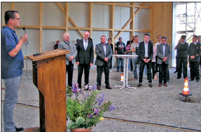
Die Holzständerbauweise ist ein Markenzeichen des neuen Frickenhäuser Feuerwehrhauses, dessen Richtfest nun gefeiert wurde. Kommandant Matthias Ganz (am Rednerpult) hob die enorme Eigenleistung der Wehrleute bei dem Mammutprojekt hervor. Seinen Worten lauschten auch (hinten von links) Bürgermeister Reiner Laudenbach, Landrat Eberhard Nuß, MdL Manfred Ländner, der VG-Vorsitzende Markus Schenk, zweiter Bürgermeister Martin Reinhard, Kreisbrandinspektor Heiko Drexel, Kreisbrandrat Michael Reitzenstein, Kreisbrandmeister Christoph Frank und Ehrenkreisbrandinspektor Alois Schimmer.
