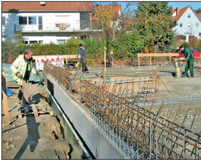
Sie buddeln, betonieren und rütteln: Aktive der Freiwilligen Feuerwehr Frickenhäuser bauen viel selbst am neuen Gerätehaus an der Ochsenfurter Straße. Sie opfern dafür ihre ganze Freizeit und sogar ihren Urlaub. Inzwischen sind die Fundamente geschaffen und die Grundrisse der Räume zeichnen sich ab.
