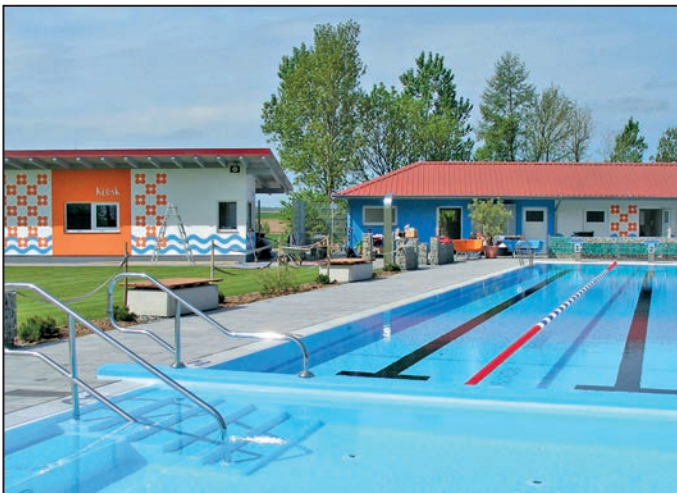
Farbenfroh und mit nezeitlichen Attraktionen ausgestattet präsentiert sich nach der Sanierung das Schwimmbad der Marktgemeinde Gelchsheim, das direkt am Gaubahn-Radweg Ochsenfurt-Röttingen liegt.
