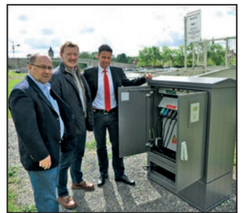
Fred Scholz (Handlungsbevollmächtigter ÜWS); Peter Juks (Bürgermeister von Ochsenfurt) und Volker Hofmann (Geschäftsführer ÜWS) nahmen die Landstromversorgung bereits am 13. Mai 2017 offiziell in Betrieb.
