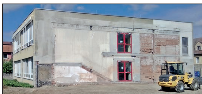
Das Würfelgebäude westlich der ehemaligen Grundschule fiel der Abrissbirne nicht zum Opfer und wird einer Generalsanierung unterzogen
