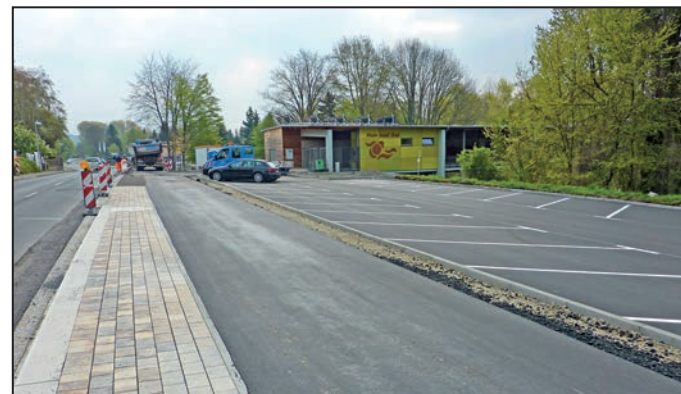
Der neugestaltete Bereich am Ochsenfurter Schwimmbad, links die barrierefreie Bushaltestelle dann der Radweg und der Parkplatz
