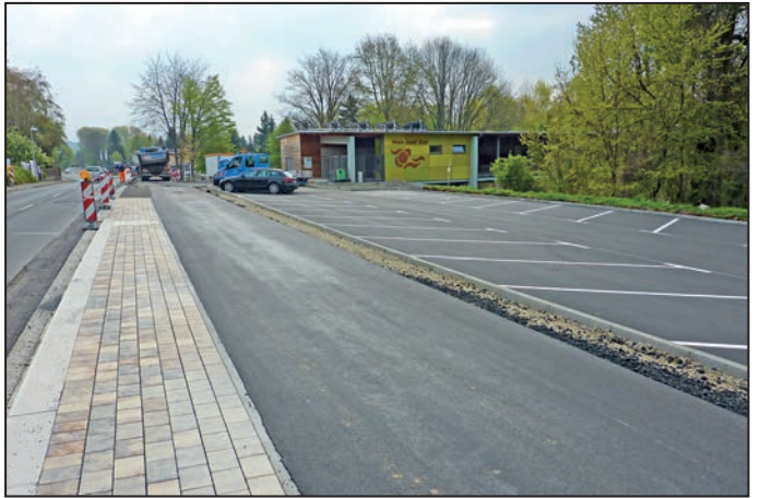
Der neugestaltete Bereich am Ochsenfurter Schwimmbad, links die barrierefreie Bushaltestelle dann der Radweg und der Parkplatz
