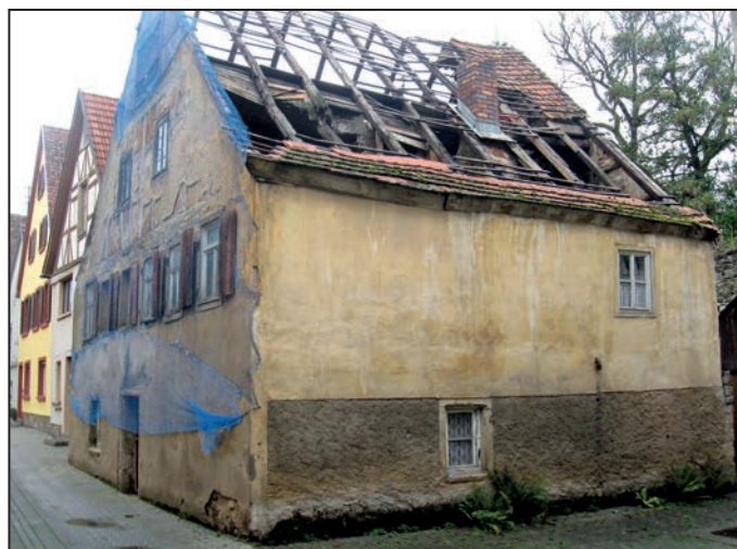
Ein ehemaliges Wohnhaus in der Mühlstraße in Aub kann abgebrochen werden.
